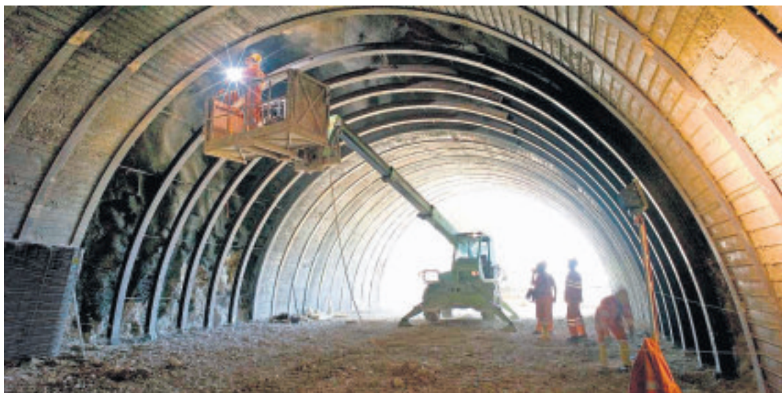
Travaux dans le tunnel de Montaigne. | PHOTO C. STADELMANN ET N. CHÈVRE
